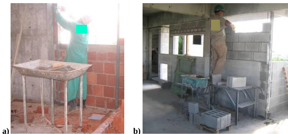
Figura 1 – Processo construtivo: a) tradicional, b) racionalizado.
