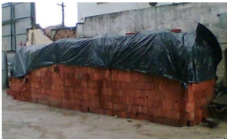
Figura 5 – Tijolos expostos à chuva (obra 1)
