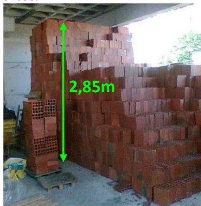
Figura 6 – Estoque definitivo de tijolos (obra 1)
