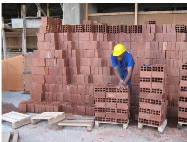
Figura 2 – Tijolos paletizados em obra (obra 3)
